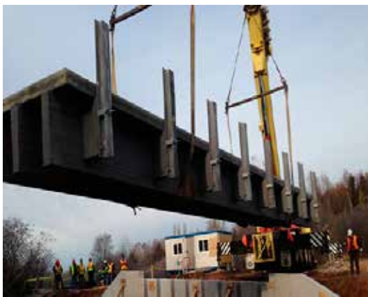
Строительство моста из стеклопластика через р. Пашенка
